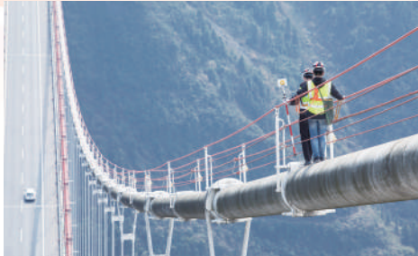
矮寨大桥项目现场。
