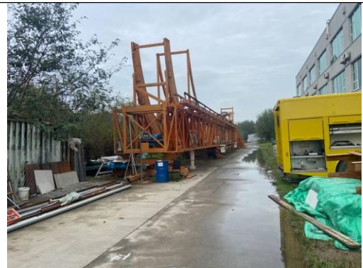
西侧为草地及场内道路
